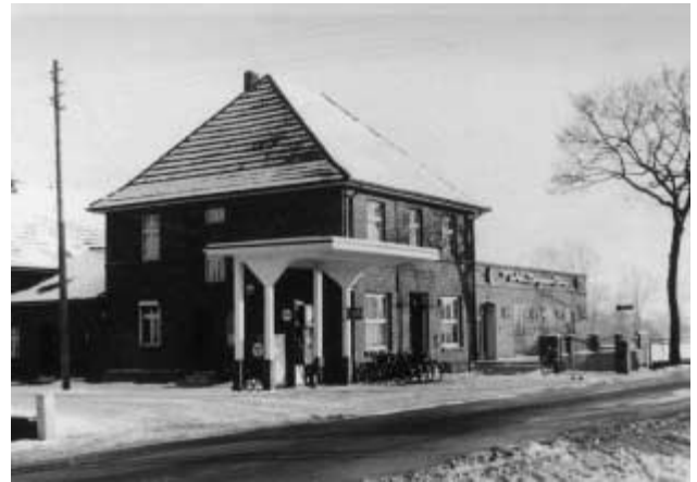
100 Tage Kälte gab's im Winter 1962/63. Der verschneite Wintergarten an der Dingener Straße
