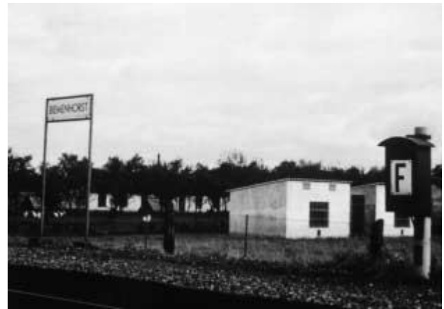
...und an der Ostseite der Eisenbahnstrecke Bocholt-Wesel
