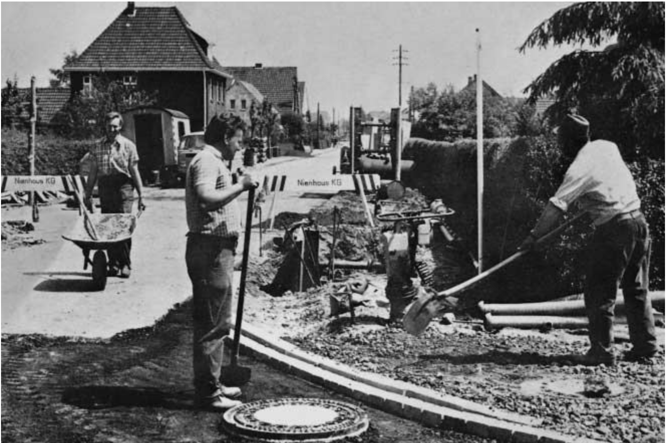
Kanalbau im Einmündungsbereich Birkenallee - Dingener Straße mit Blick auf die Birkenallee
