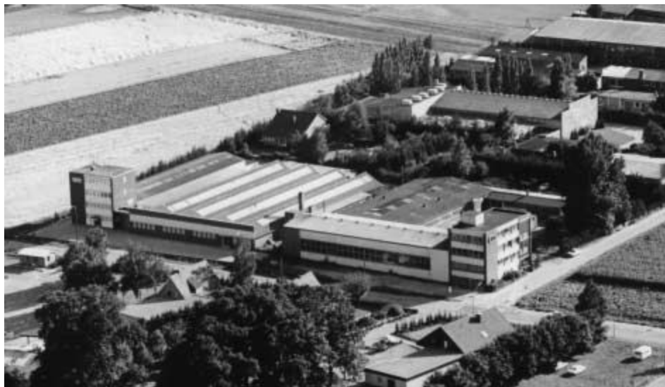
Das Industriegebiet an der ehemaligen Grenzstraße (heute Bernhard - Otte - Straße) Ecke Bürgerner Straße: Auf dem freien Ackergelände links wird jetzt (1999) die neue Bundesstraße (B67) gebaut. Aufnahme aus dem Jahre 1975
