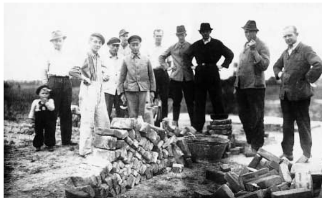
Baubeginn des Clubheimes im Sommer 1949. Die fleißigen Helfer waren: von links nach rechts: Karl Wüpping, Heinz Pipenrock, Hermann Dreckmann, Franz Sauret, Willi Kamps, Bernhard Hübers, Karl Neumann und Johann Ridder.
