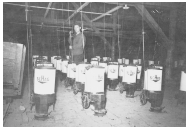
Brenner Franz Theißen mit der halbautomatischen Befeu- rungseinrichtung für Staubkohle auf dem Ringofen
