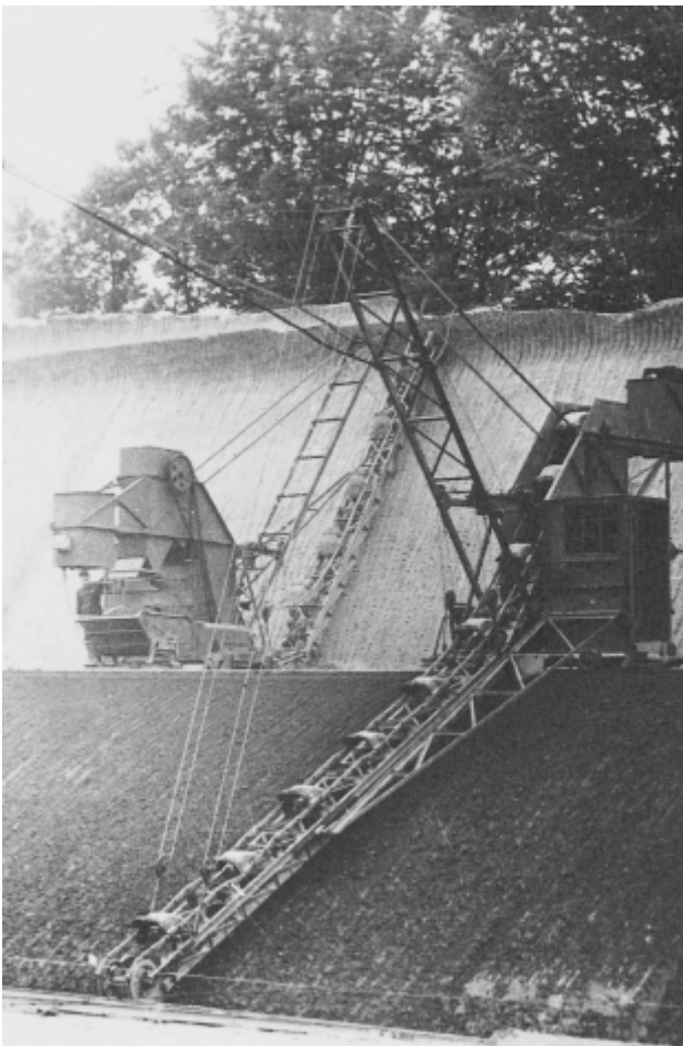
Eimerkettenbagger in der Lehmgrube von Orthaus und Tacke 1954
