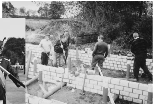
Fundamente, viele Rohre ...
