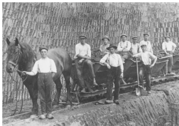
Abtransport der gefüllten Loren durch Pferde aus der Lehmgrube der Ziegelei Lueb, mit den Arbeitern Reinhold Henke, H. Schlüter, G. Schepers, R. Grümping und Th. Gielink
