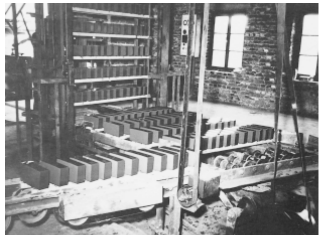
Die Steinrohlinge verlassen die Strangpresse und gehen über Absetzwagen zur Trocknung, Ziegelei Vallée
