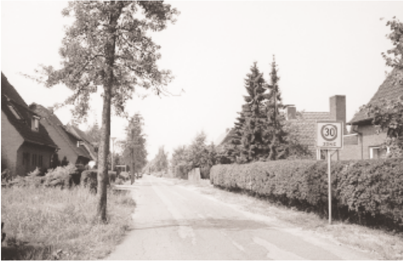
Mittelheggenstraße vor dem Ausbau ...
