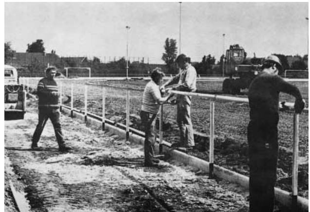
Bau des neuen Sportplatzes im Juni 1974
