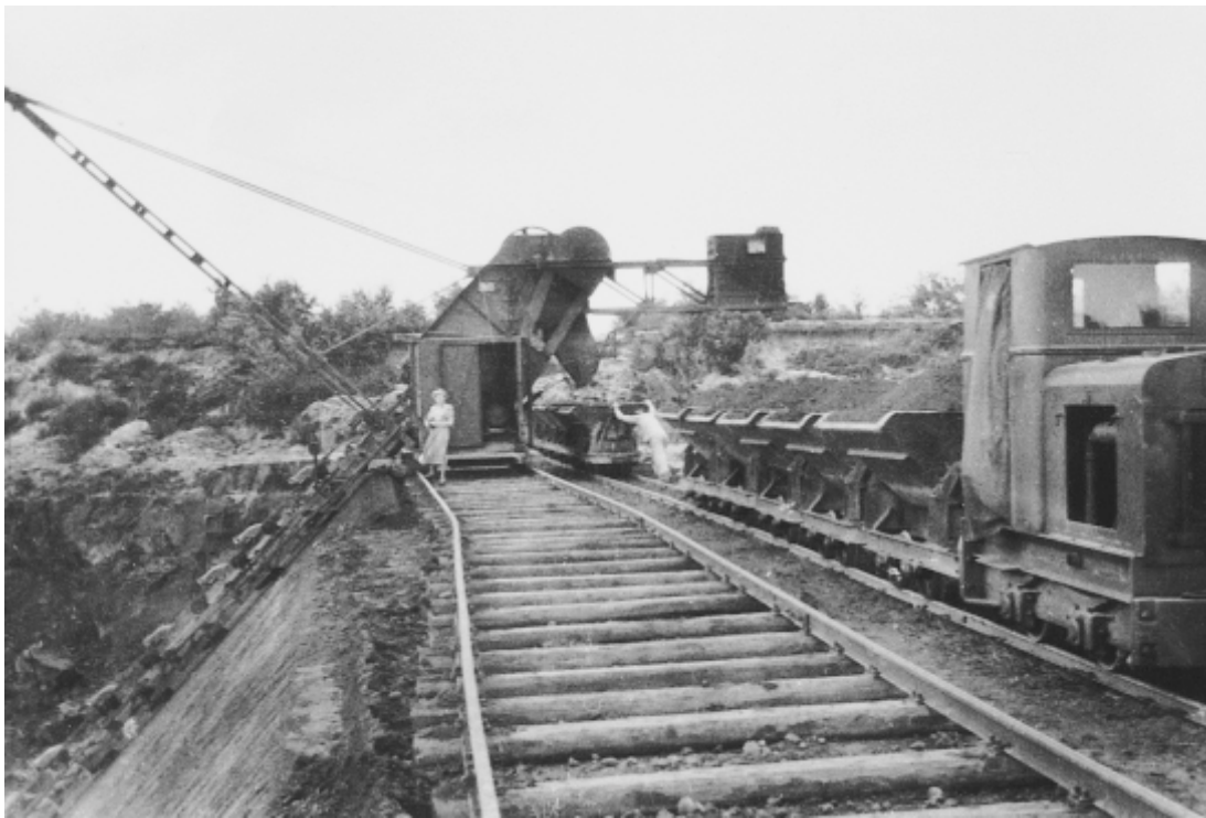
Eimerkettenbagger und Lorenbahn am Lehmberg von Werk II
