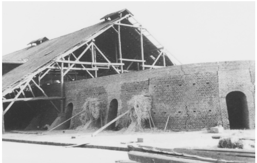
Teilweise abgebrochenes Ringofendach mit zwei neugegossenen Fundamenten für die Stützpfeiler der neuen Dachkonstruktion Verkleidung der Fundamente mit Stroh als Frostschutz ...
