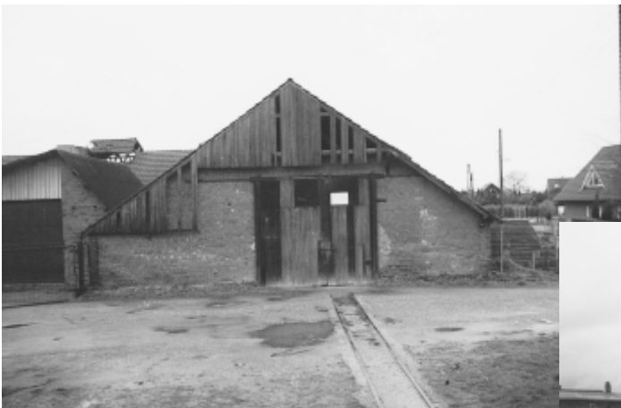
Die Schienen führen in das Gebäude, wo sich früher der Kollergang befand
