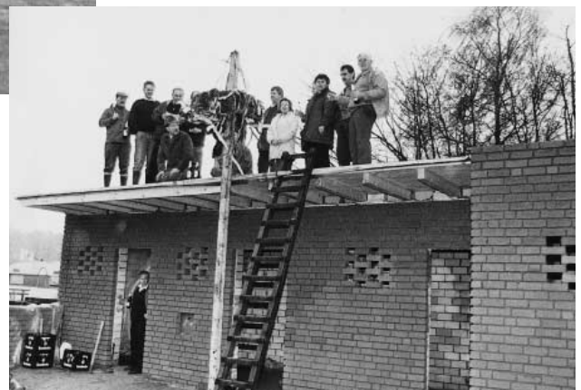
... und Richtfest der Toilettenanlage
