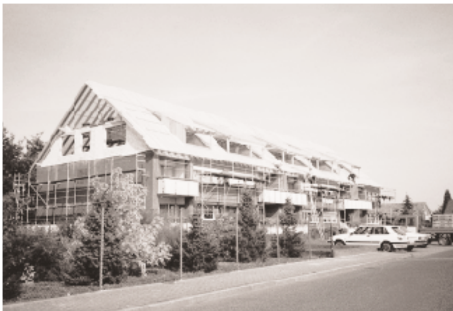
Vom Flachdach zum Spitzdach, Wohnblock an der Straße Im Feld am 17.10.1992
